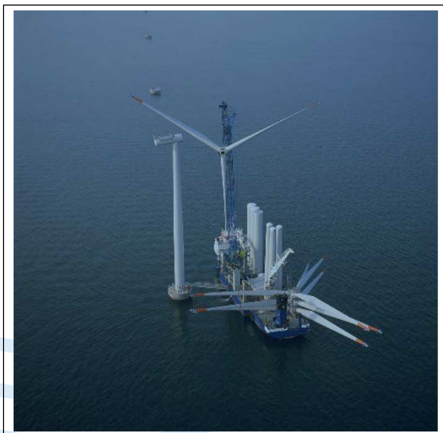
Figur 7 Illustrasjonsfoto – montering av 2,3 MW vindmøller i Nysted havmøllepark i Danmark
